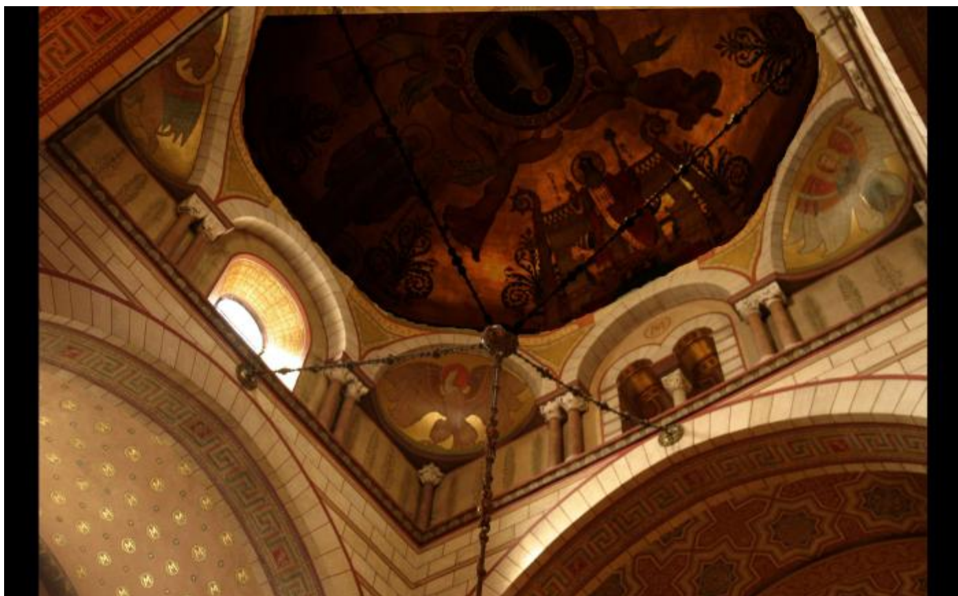
Figure 19 : coupole d'Ainay avec ses trompes décorées par des colonnes multiples
