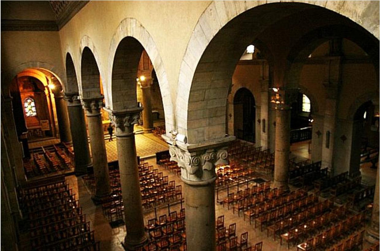
Figure 15 : Colonnade de la nef avec ses chapiteaux corinthiens à feuilles grasses, les colonnes supportant la coupole s'intégrant parfaitement à l'ensemble
