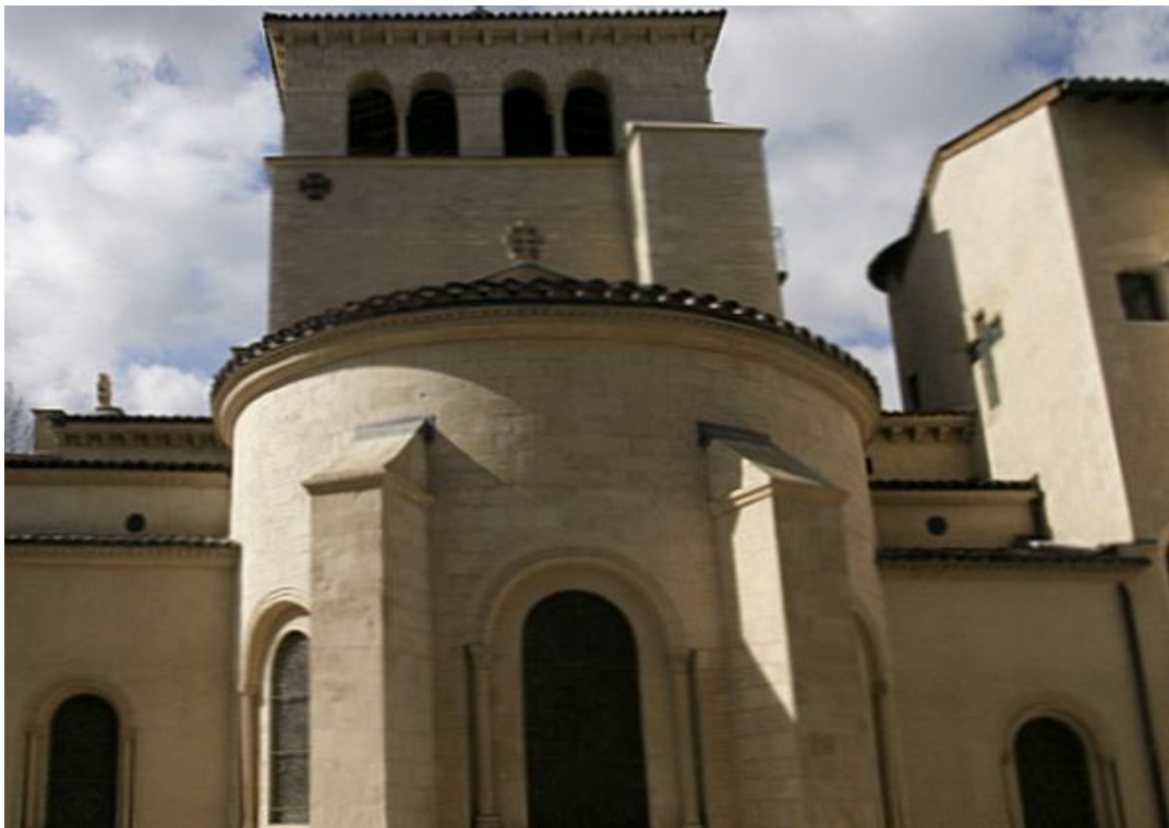
Figure 23- : Vue extérieure de l'abside avec vue sur la tour lanterne derrière l'abside. L'abside (chevet) semi-circulaire est encadrée par deux absidioles à fond plat.
