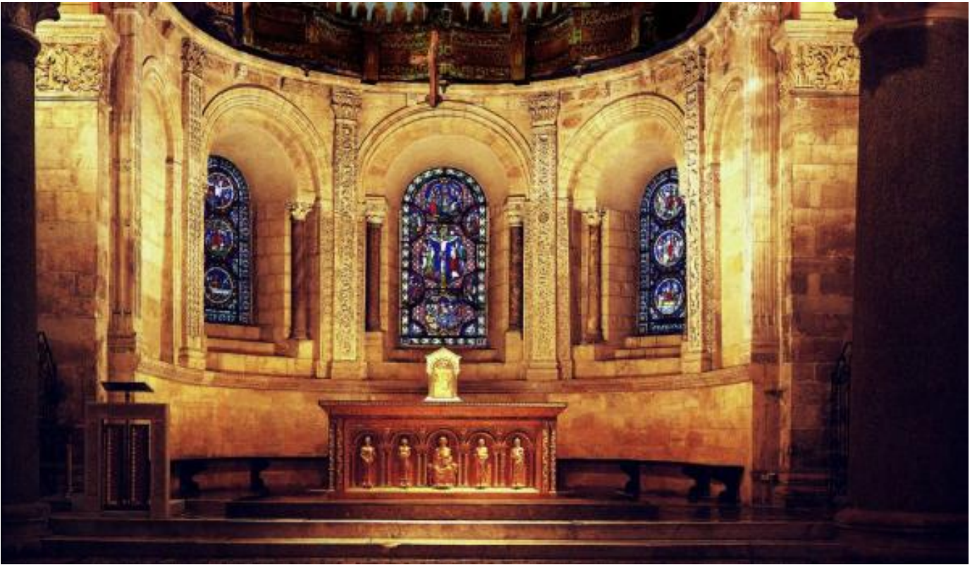
Figure 22: L'abside de Saint-Martin, semi-circulaire, encadrée par deux gros pilastres surmontés de bas-reliefs (chapiteaux) historiés
